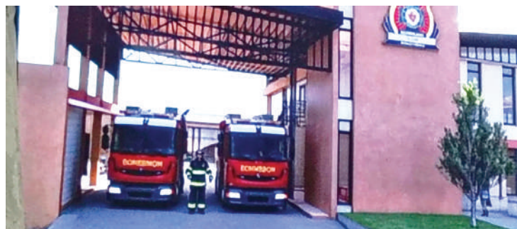
Autoridades recibieron las ofertas económicas para la construcción de la nueva subestación de bomberos.
