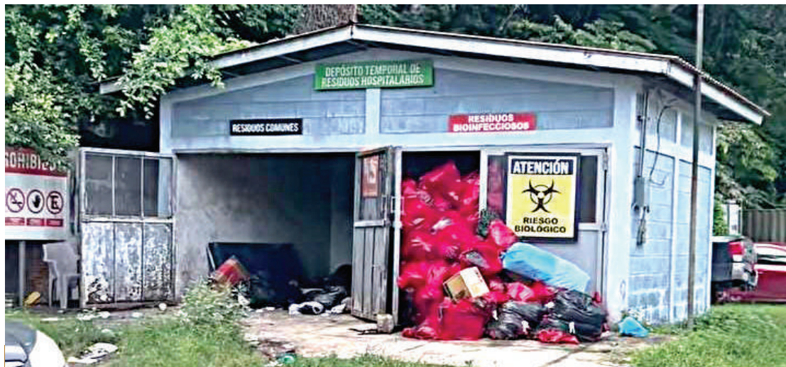
El depósito de desechos biomédicos se encuentra saturado, con materiales acumulados y expuestos.
