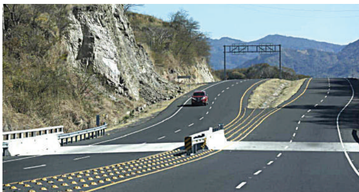
El Canal Seco forma parte de la infraestructura vial estratégica de Honduras.
