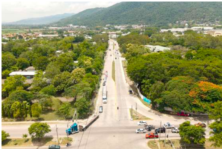
La obra ejecutada es la pavimentación de la segunda trocha de la tercera avenida Sureste; desde la 33 calle hasta la colonia Providencia en el sector Chamelecón.
