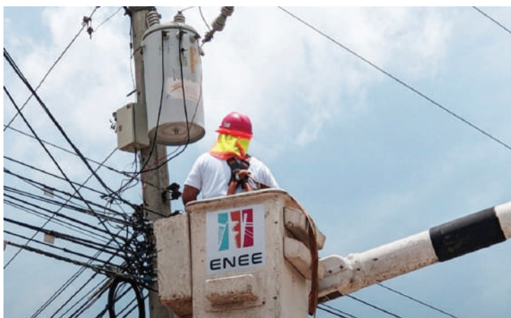
La ENEE enfrenta el desafío de reducir las pérdidas de energía y mejorar su situación financiera.
