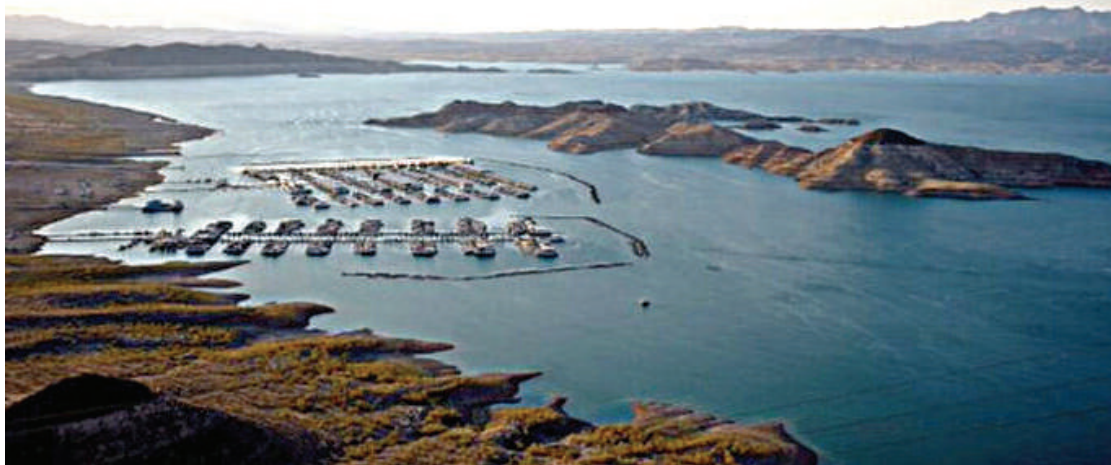
El lago Mead es una de las principales reservas de agua del suroeste estadounidense.
