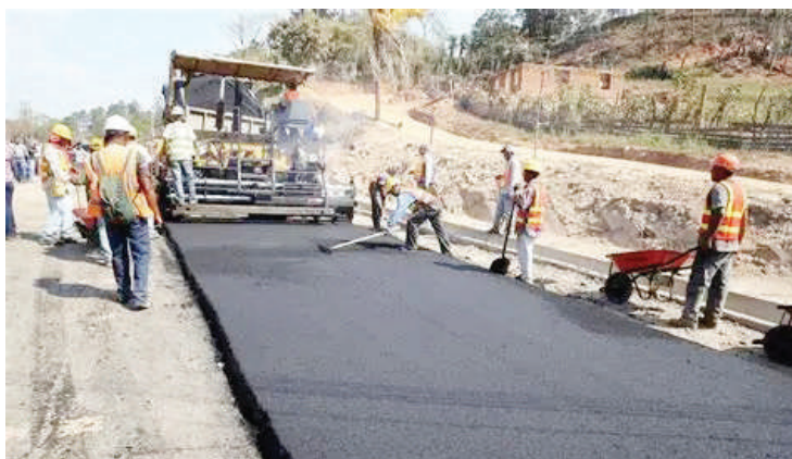
Obras de infraestructura forman parte de los proyectos que serán reactivados.
