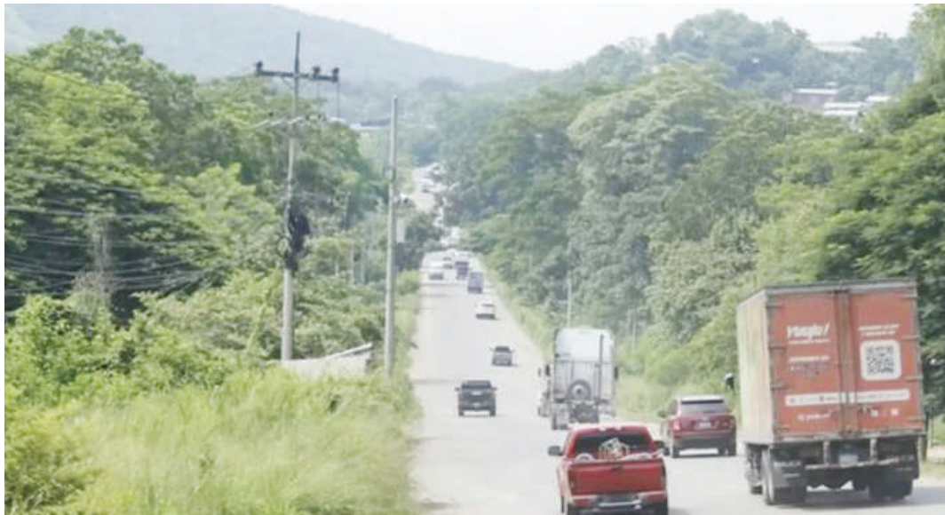
La intervención en la carretera CA-4 pretende disminuir los tiempos de desplazamiento y fortalecer la movilidad en la zona norte.
