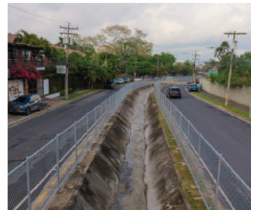
Construcción del cerco perimetral de seguridad en el canal Los Arcos, ubicado en la residencial Los Arcos, bulevar del sur. Un proyecto que salva vidas.
