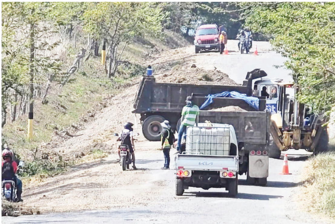
Los trabajos de reparación avanzan para dar mejor vialidad en la zona.
