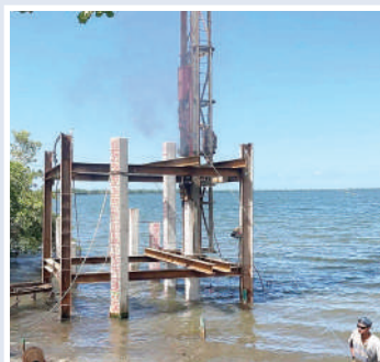
Se ha iniciado el hincado de pilotes.
