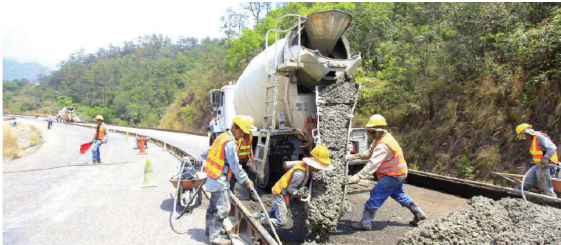
Obras viales avanzarán en Honduras con inversión millonaria y alcance nacional.
