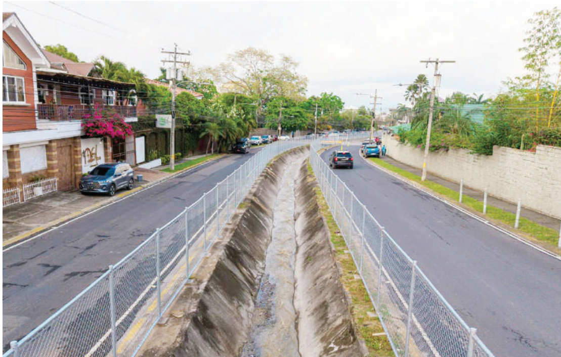
El proyecto consiste en la construcción del cerco perimetral de seguridad en el canal Los Arcos.
