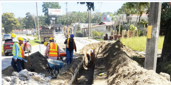
Los trabajos están impactando ahora en el sector de barrio Cienaguaita.
