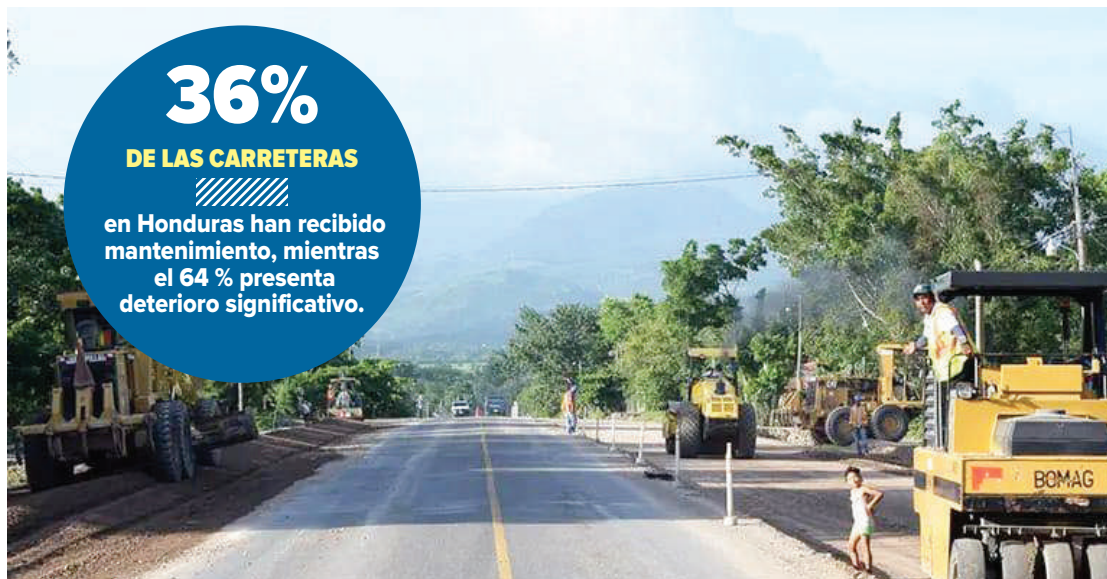
Trabajos viales se ejecutarán en un plazo aproximado de 60 días.
