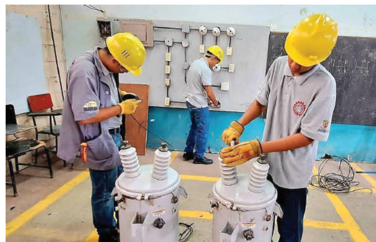
Jóvenes del área técnica de electricidad industrial.
