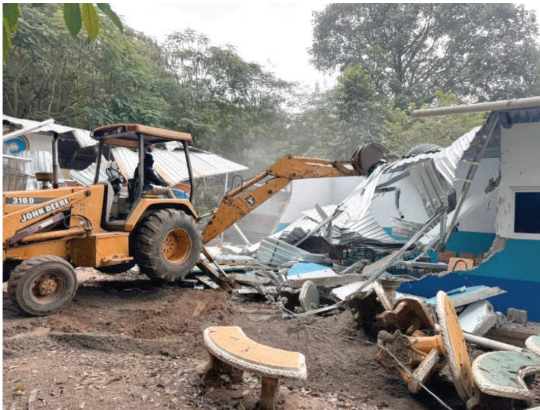
Maquinaria pesada derriba viviendas en la colonia El Palmar, Cofradía (Cortés), durante el desalojo que dejó a 250 familias sin hogar.
