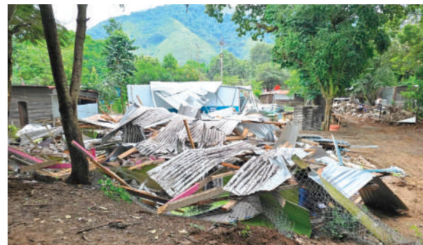
Viviendas quedaron reducidas a escombros tras el desalojo ejecutado con maquinaria pesada en El Palmar, Cortés.
