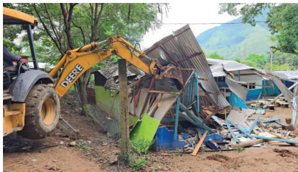
Maquinaria pesada derribó viviendas durante la ejecución de la orden judicial en El Palmar, Cortés.
