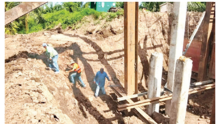
Ya han comenzado a colocar los pilotes para la nueva estructura.
