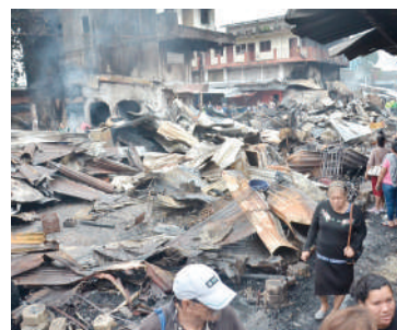
Láminas retorcidas y estructuras colapsadas tras el incendio en el Mercado Medina.
