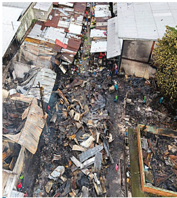
Imagen panorámica de la destrucción y caos que dejó el devastador siniestro en el Mercado Medina.
