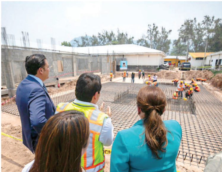
La Presidenta Xiomara Castro en la supervisión de la construcción del búnker oncológico del Hospital San Felipe de Tegucigalpa.
