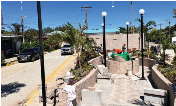
Obras de infraestructura por los cuatro puntos cardinales ejecutados.
