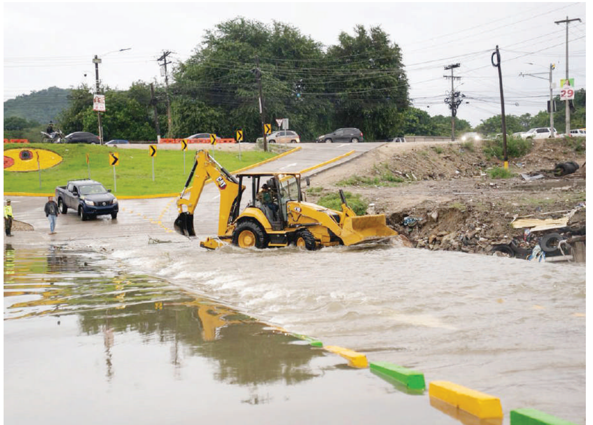
Los vados están habilitados para el paso vehicular.
