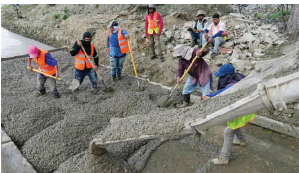
La obra consiste en la pavimentación de 13,881.44 metros cuadrados con concreto hidráulico de 20 centímetros de espesor.
