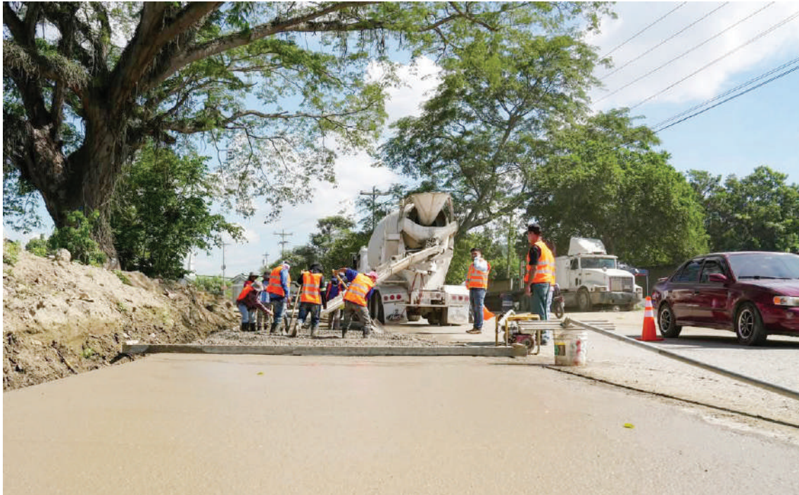
Con trabajos de fundición, avanza el proyecto de pavimentación de la trocha oeste del bulevar de acceso a Los Cármes.
