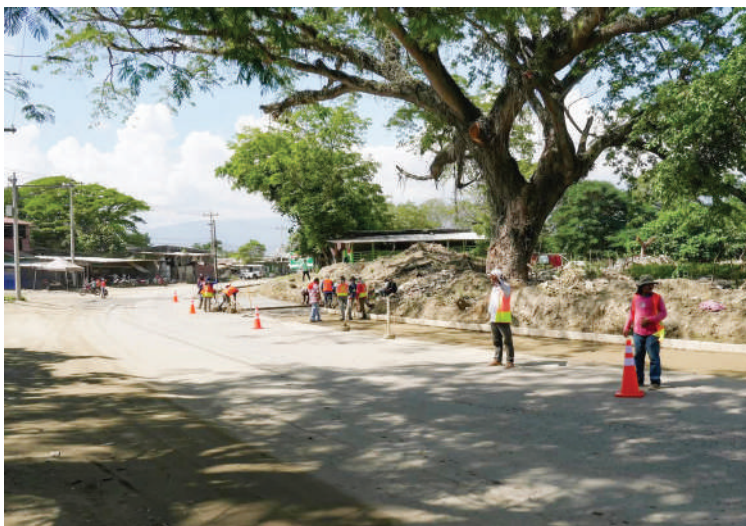
Esta es una de las obras viales más esperadas por los vecinos de la zona.
