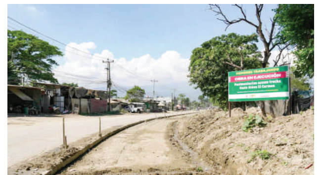
Con este proyecto el alcalde Roberto Contreras busca mejorar la movilidad, seguridad y conectividad de este importante punto de la ciudad.
