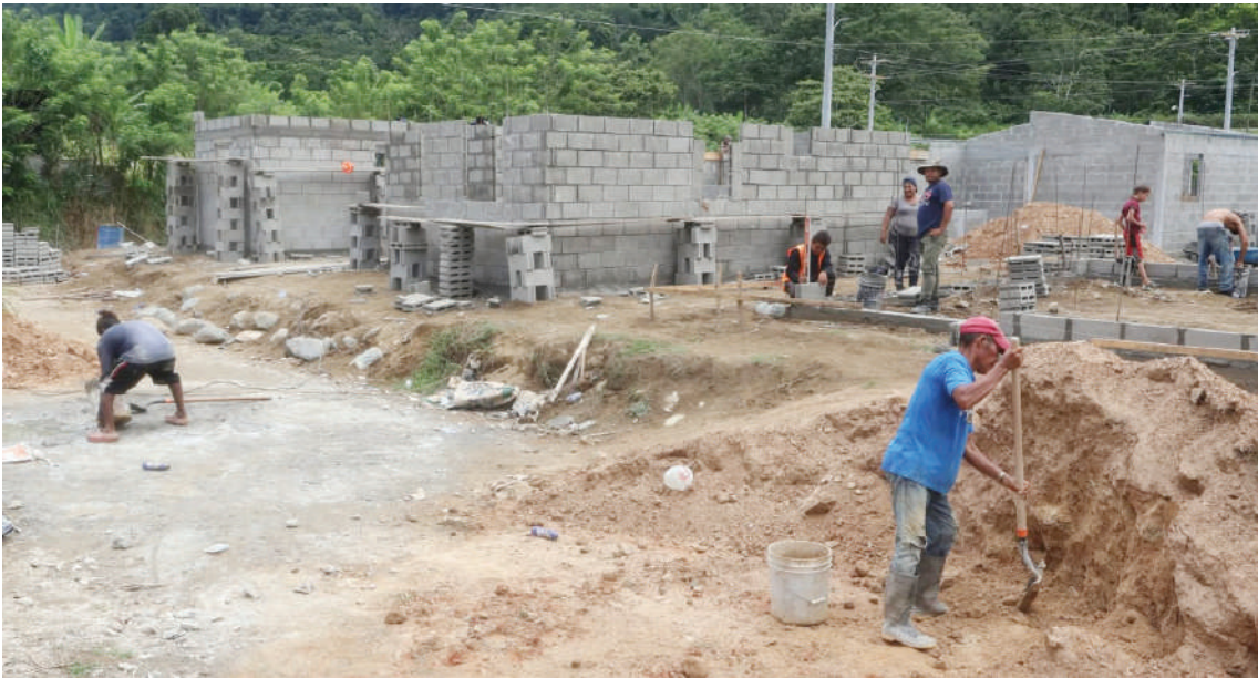
Las viviendas están bien avanzadas en su construcción.
