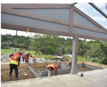
Los trabajos ya comenzaron y culminarán antes de dos meses.
