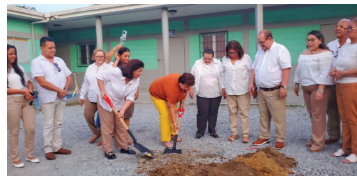
Ya trabajan en las labores de ampliación.
