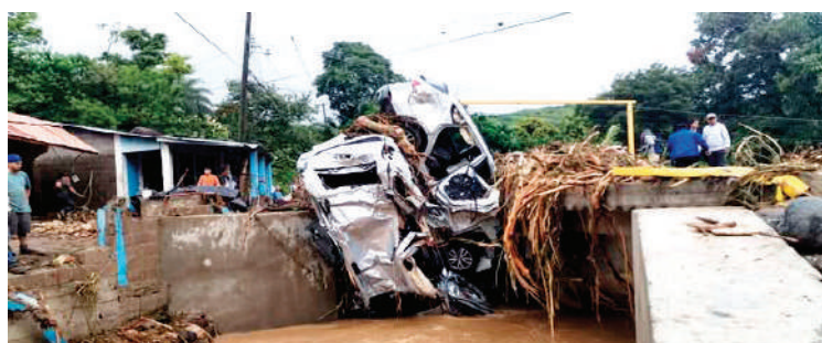
Dos vehículos quedaron apilados y totalmente destruidos sobre un puente tras ser arrastrados por la corriente del río en Río Abajo, Tegucigalpa.
