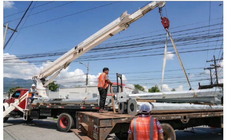
Esta semana se ha estado trabajando en la instalación de postes.
