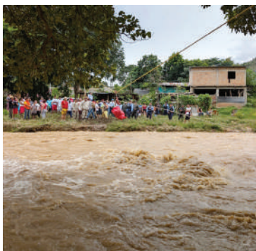
Vecinos improvisaron una garrucha con lazos y una silla para cruzar el río Vallecillo tras el colapso del puente.
