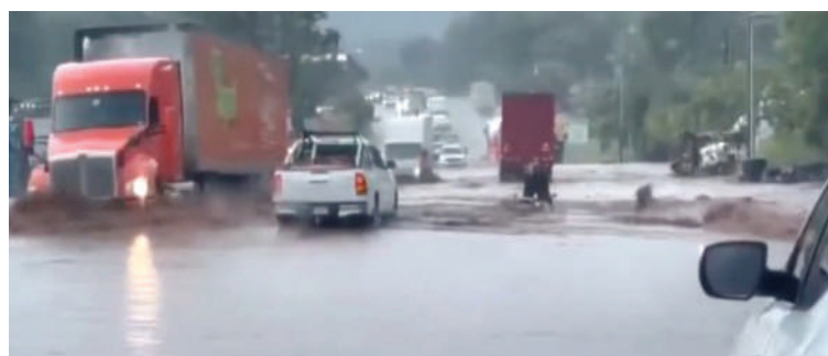
El desbordamiento de una quebrada a la altura de Taulabé, Comayagua, sobrepasó la carretera CA-5.
