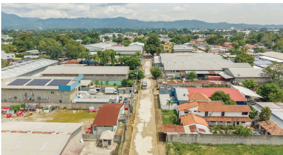
El proyecto consistió en la pavimentación de la 3 avenida con concreto hidráulico MR600, con una longitud de 275.00 metros lineales.
