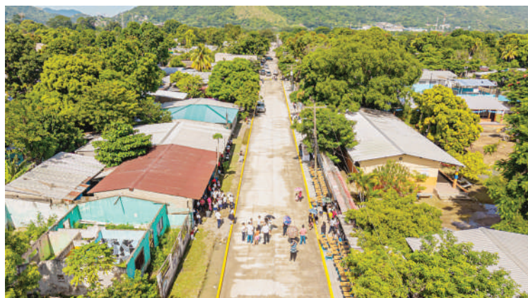
El proyecto consistió en la construcción y pavimentación de la calle principal de la colonia Ebenezer con concreto hidráulico.
