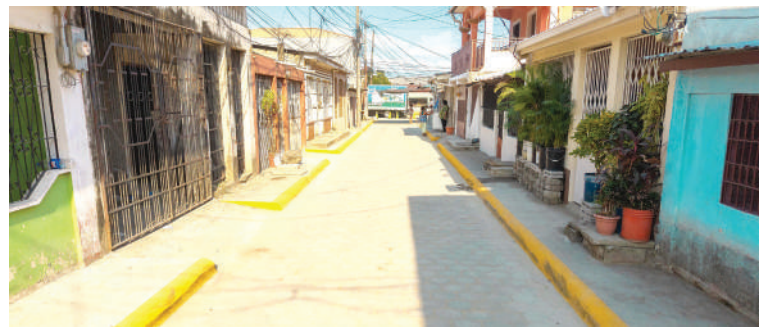
La obra contempló la pavimentación de la calle de acceso al centro educativo 15 de Septiembre, mejoramiento y sustitución de canales de aguas lluvias.
