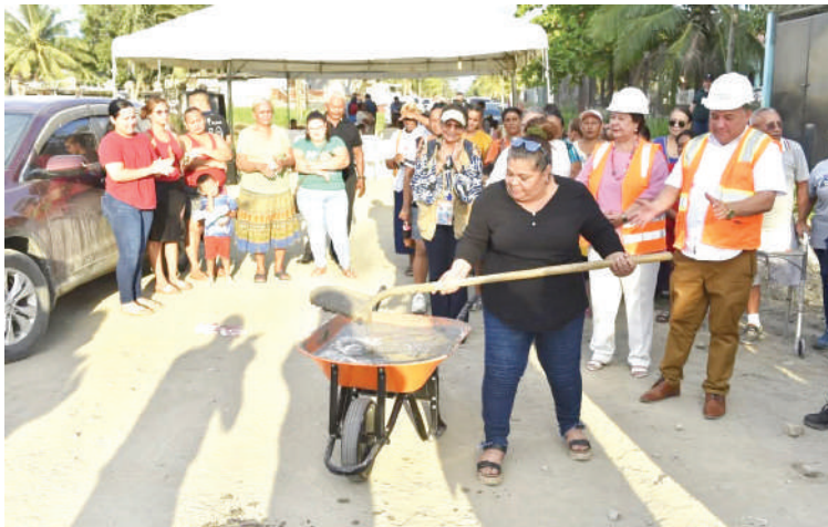
La primera palada de concreto se tiró sobre la vía que será pavimentada.
