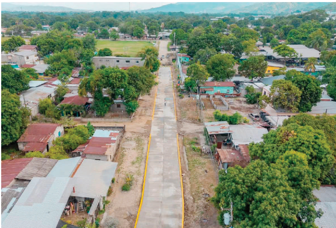
El proyecto entregado es la pavimentación con concreto hidráulico de la 3 Calle y 6 Avenida en la colonia San Antonio.
