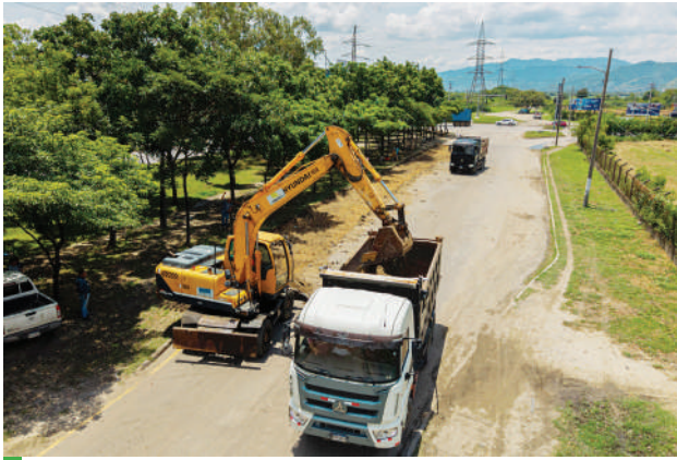
La obra consiste en la construcción y pavimentación de la trocha oeste con concreto hidráulico MR 650.
