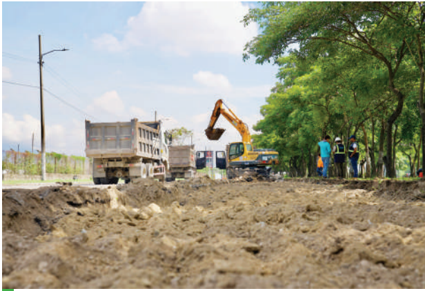
Con la remoción de la carpeta asfáltica y topografía, iniciaron los trabajos.
