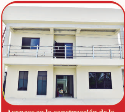
Avances en la construcción de la Casa del Adulto Mayor
