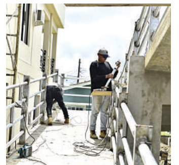
La edificación está casi terminada, por ahora se trabaja en los detalles.
