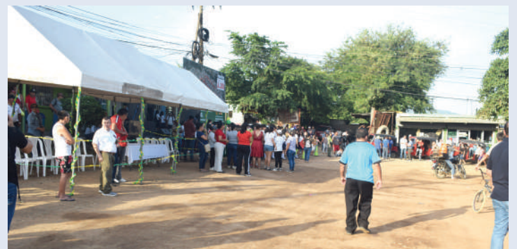
La obra de pavimentación de esta calle de acceso a la colonia Dos Mil, inicia este lunes 11 de agosto.
