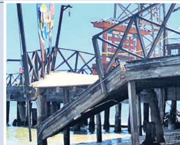
Olas golpean la plataforma dañada del muelle de Tela, clausurada por riesgo estructural luego del incidente que dejó tres lesionados.
