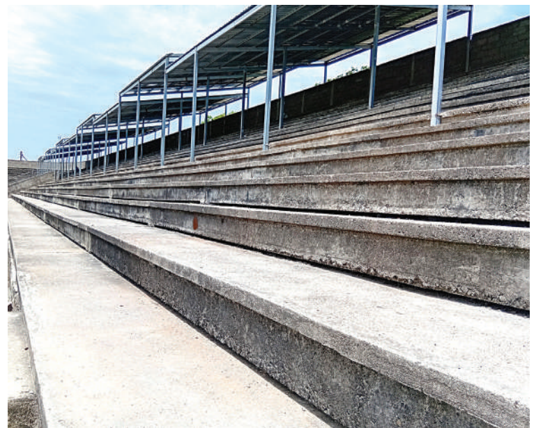
Las instalaciones serán pintadas en los próximos meses.
