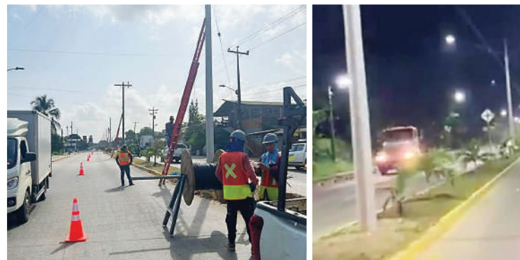
Los proyectos se han estado ejecutando por etapas.
