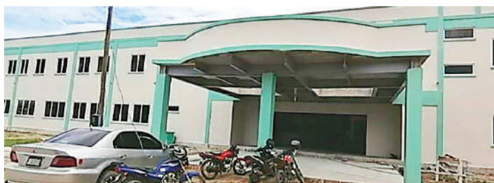
Al hospital aún le faltan algunos detalles.
