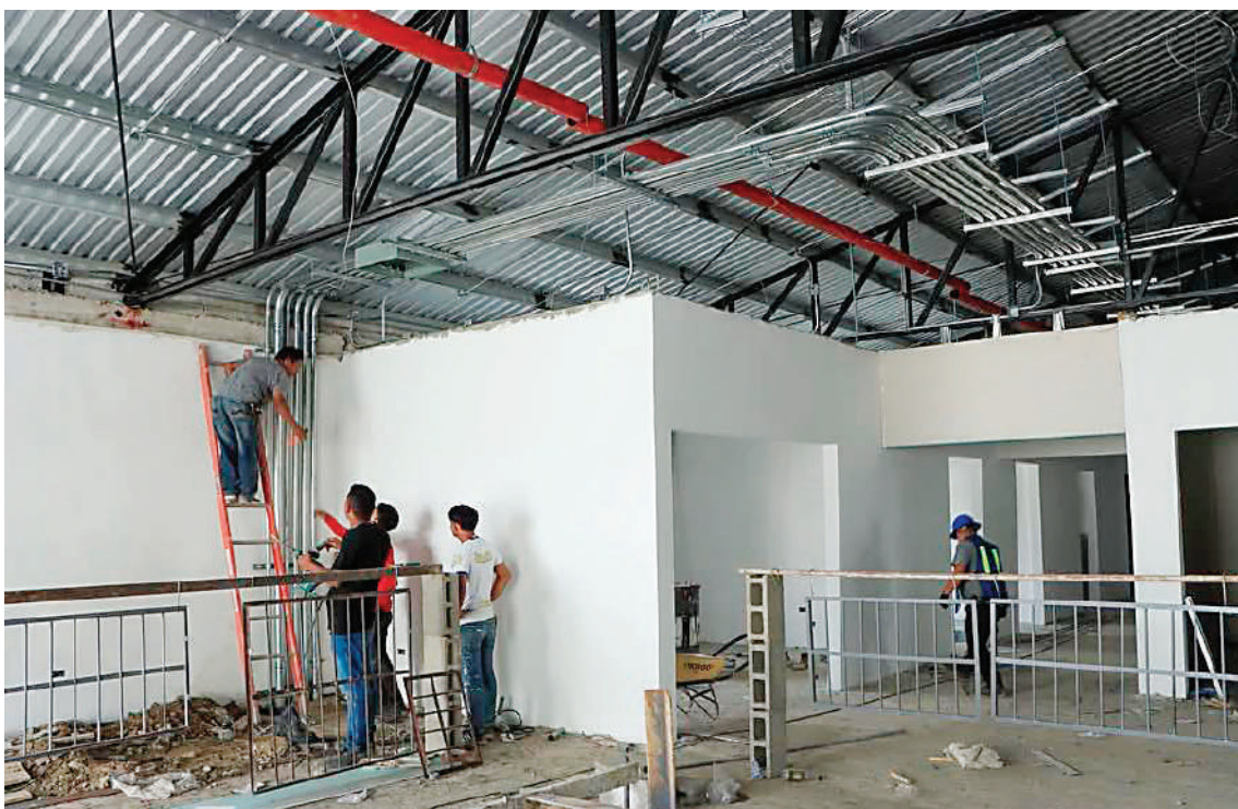
Los equipos municipales avanzan con los trabajos en las instalaciones especiales; las tuberías y los ductos para el oxígeno y aires acondicionado.
