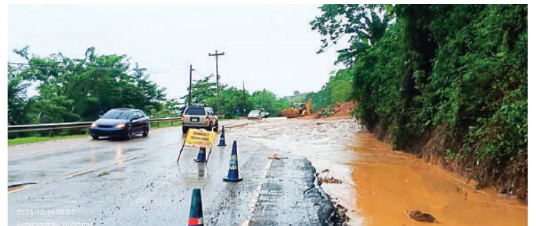
La carretera ha sido severamente dañada por los aguaceros y deslaves.
