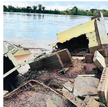
Las lluvias han provocado severos daños en este camposanto.
