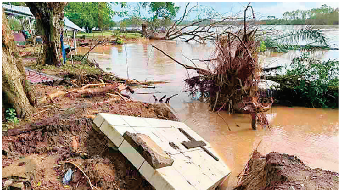
Alrededor de 60 tumbas del cementerio de Chapagua, fueron arrastradas por las embravecidas aguas del río Aguán.
