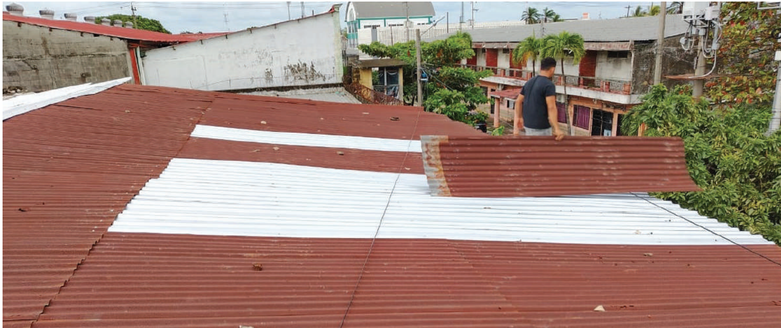
Por ahora se hacen trabajos de emergencia en el techo de la Policía porteña.
