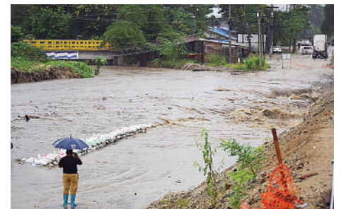
Una de las áreas más críticas es la plancha de Cemcol, la cual colapsó.
