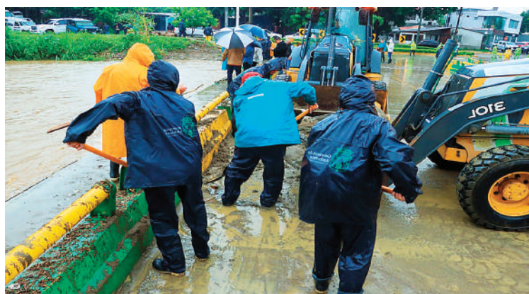
Las cuadrillas municipales llegaron al sector de Jucutuma para seguir con los trabajos de reparación del puente.
