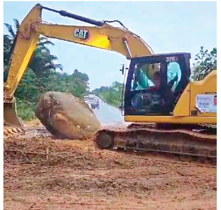
Máquinas trabajan para habilitar calles dañadas por las fuertes lluvias.
