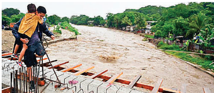
La tormenta tropical Sara dejó pérdidas millonarias en la infraestructura.
