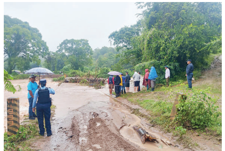
Las intensas lluvias también colapsaron el puente Río Grande, en Orica, Francisco Morazán.
